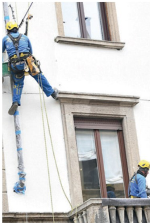
Un cantiere edile su un palazzo di Milano (ANSA)
