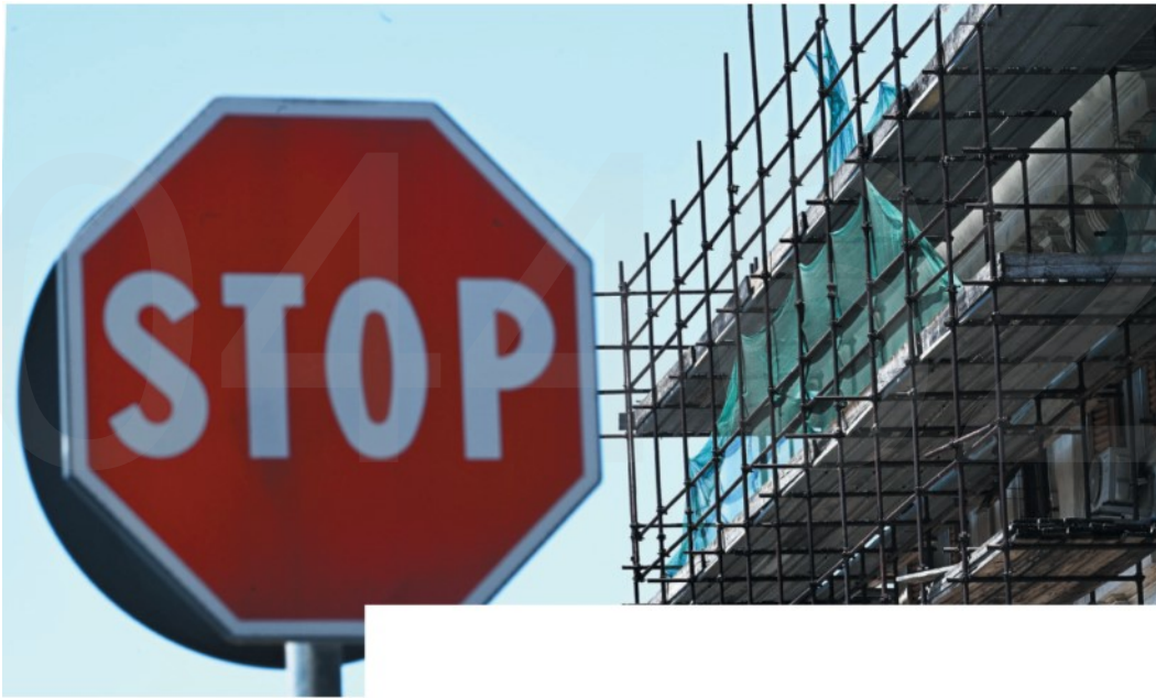
Un cantiere a Genova ANSA
